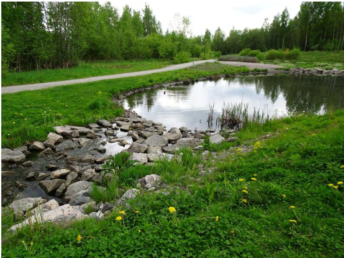
Kuva 10. Esimerkkikuva hulevesialtaasta (© Päijät-Hämeen vesijärvisäätiö)
