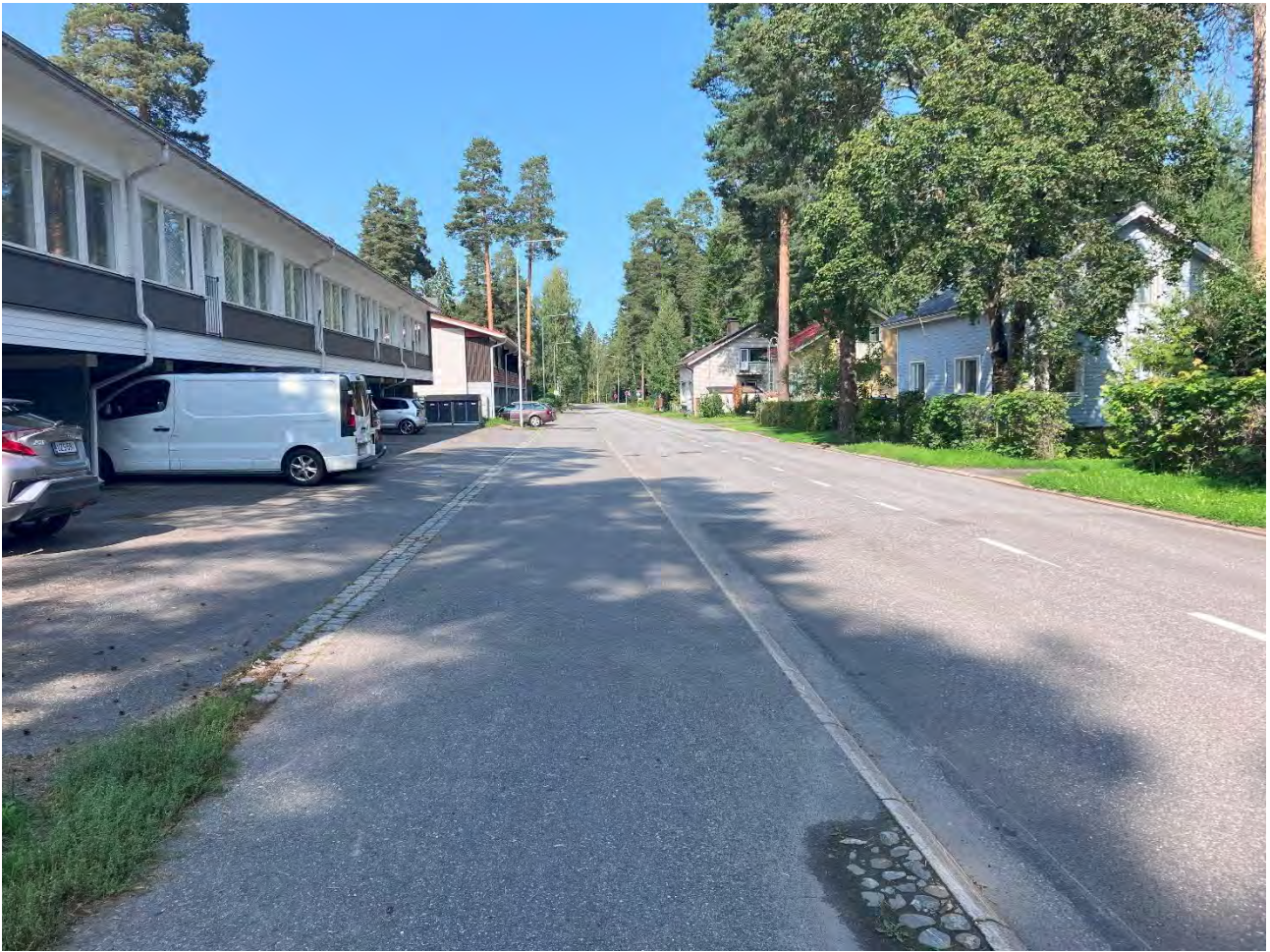
Kuva 27: Lehmuskadulla kulkeva yhdistetty jalkakäytävä ja pyörätie.
