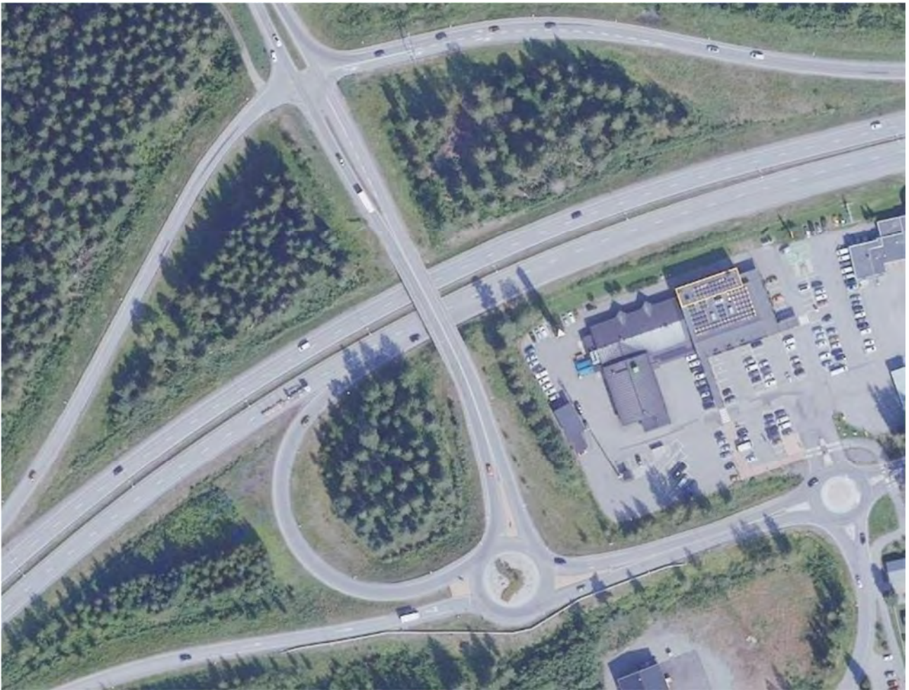
Kuva 26: Ortokuva Pitkäjärven eritasoliittymästä. (MML Ortokuva)
