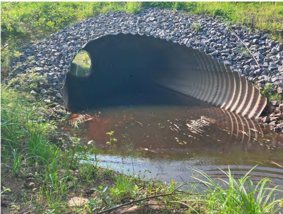
Kuva 10: Valtatie 13 ylittää Siekkilänjoen teräsputkisillalla Lentokentänkadun liittymän eteläpuolella.
