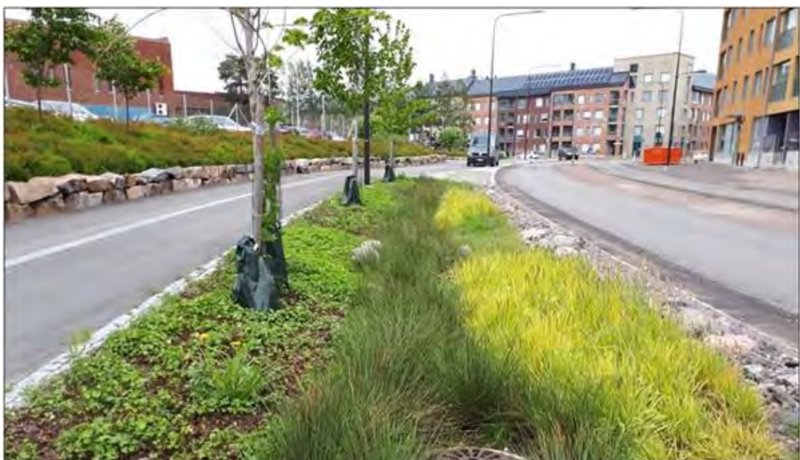
Kuva 14. Esimerkki biosuodatusrakenteesta (© Ramboll)
