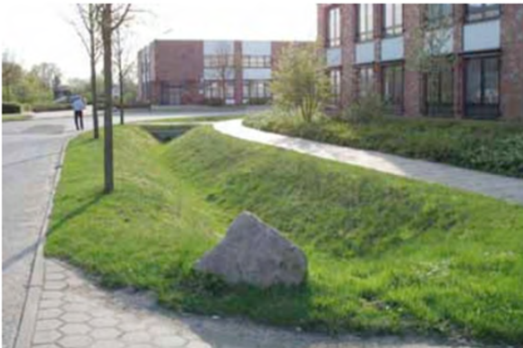
Kuva 16. Esimerkkikuva viherpeitteisestä ojasta (Hulevesiopas 2012)
